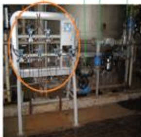
Nuovi quadri strumenti
